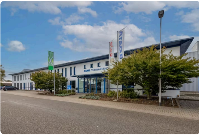
Het kantoor van ATAG Verwarming in Lichtenvoorde.
